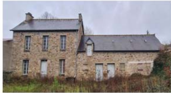
Bat. F - Façade Sud
