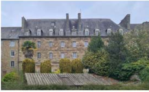
Façade Sud sur jardin Central
