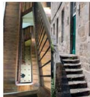
Escalier sur jardin (Sud)
