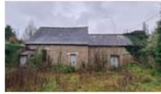
Bat. G - Façade Nord
