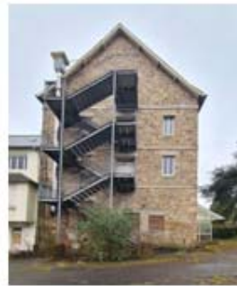
Escalier Métallique Est
